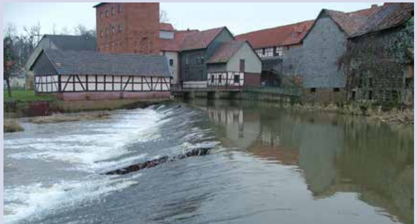
Abbildung 1: Streichwehr einer Wasserkraftanlage Foto: Koop
