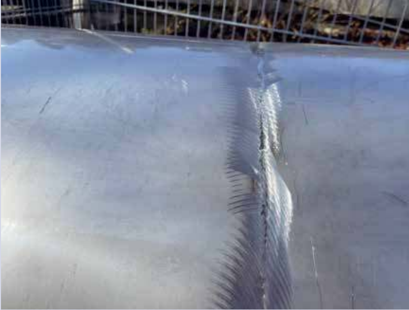
Abbildung 2: Überschliffene Schweißnaht Foto: R. H.
