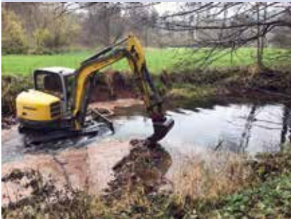
Baggern für den Naturschutz
