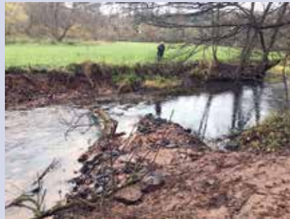
Einbau von Totholz
