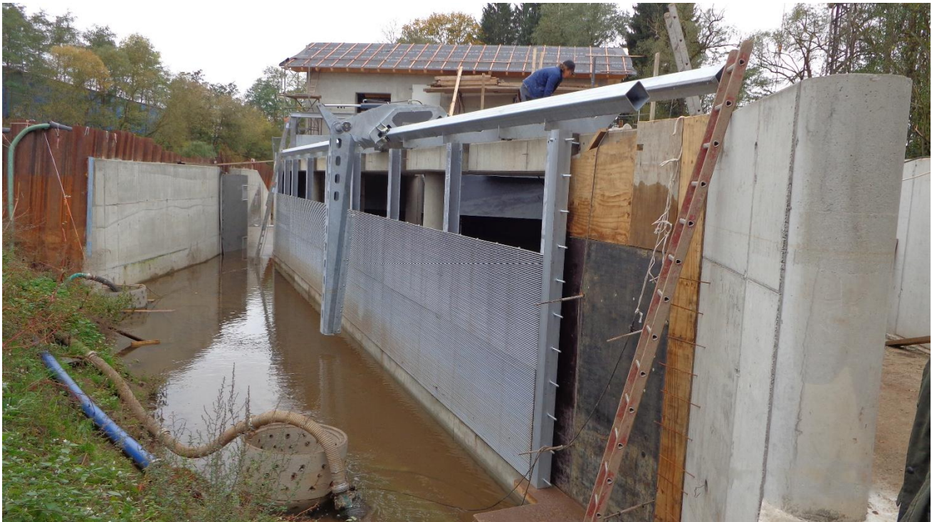
Wasserkraftanlage Lollar an der Lahn im Bau. Quelle: IG Lahn
